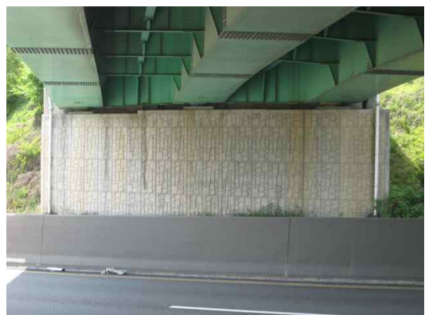
교대 A2 전경
